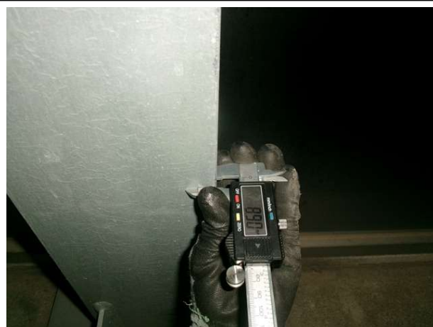
방음터널 부재치수 측정
