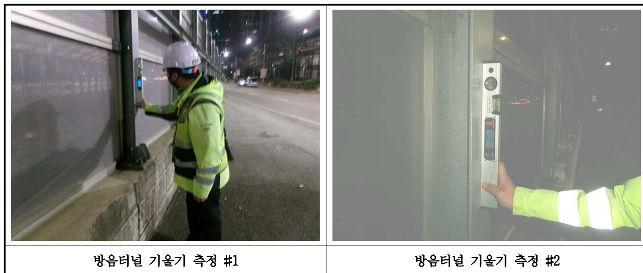
【사진 3.6.3】 경사계를 이용한 기울기 측정 현장사진
