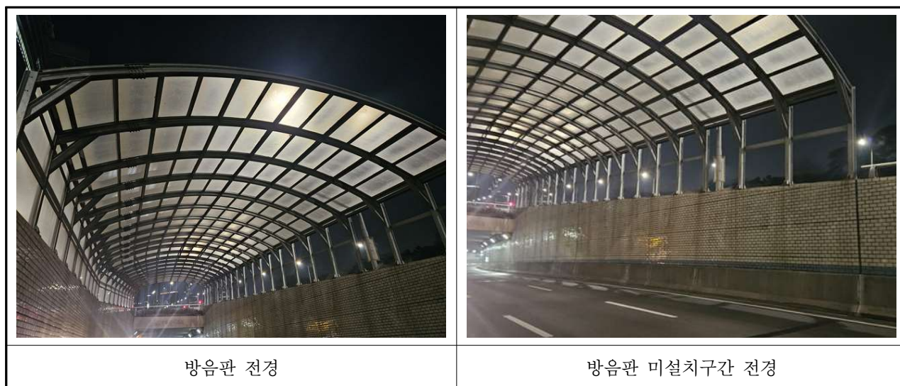
【사진 3.4.9】 방음판 전경
