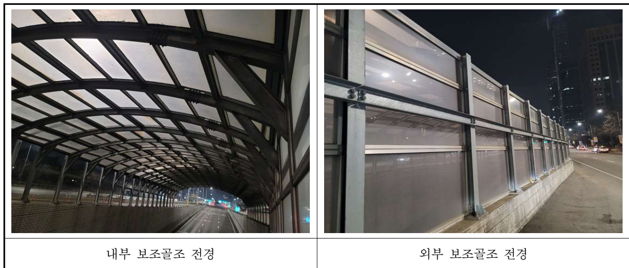
【사진 3.4.3】 보조골조 전경
