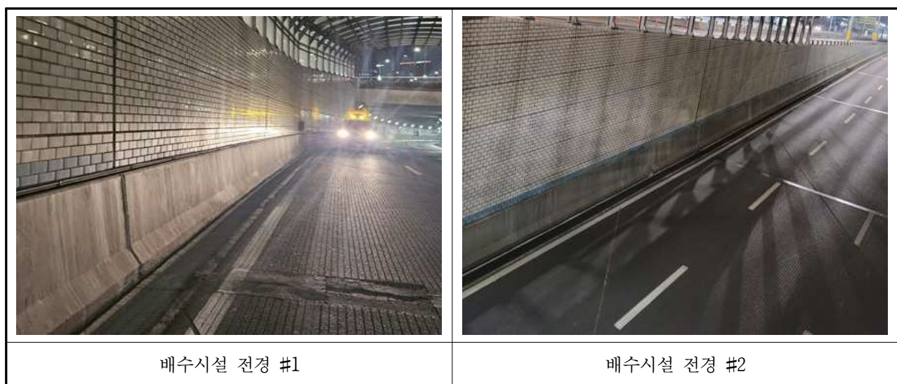
【사진 3.4.11】 배수시설 전경
